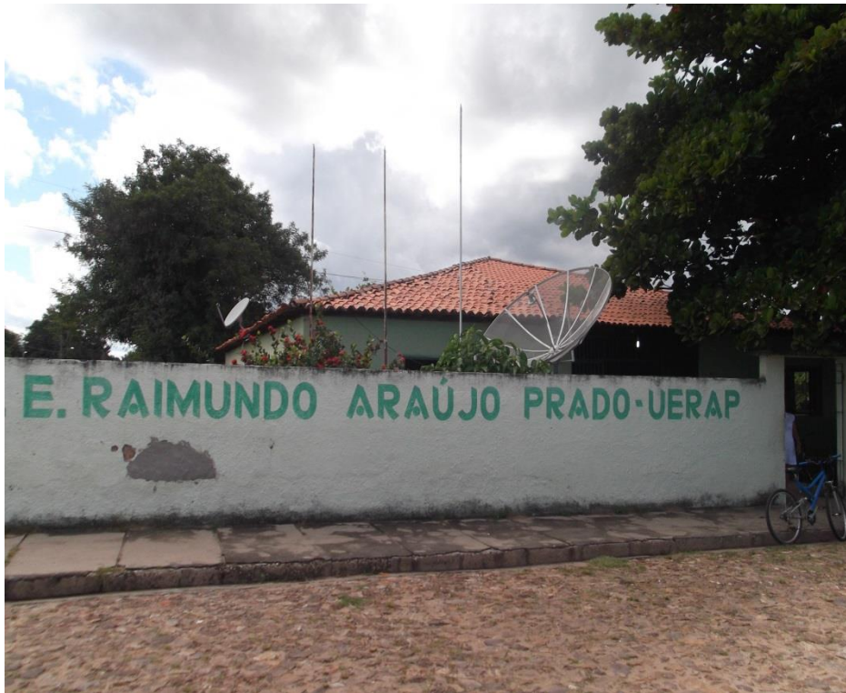
Figura 1: Unidade Escolar Raimundo Araújo Prado (área externa) Fonte: Silva (2014)
